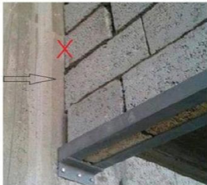
شکل ۱۱- اتصال مستقیم نعل درگاه به ستون و ایجاد پدیده ستون کوتاه
