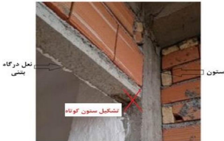
شکل ۱۱- اتصال مستقیم نعل درگاه به ستون و ایجاد پدیده ستون کوتاه
